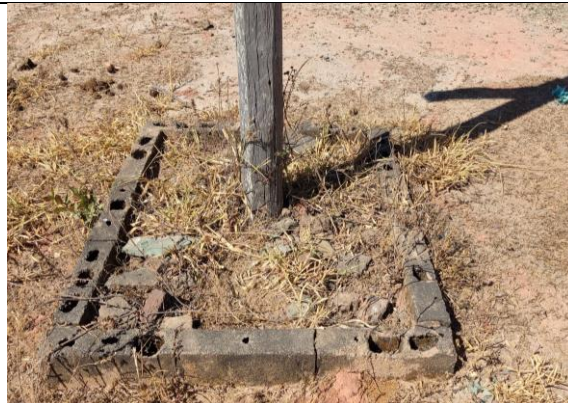
Foto 8: Detalhe do embasamento simples do cruzeiro, construído com blocos de concreto e cercado por vegetação espontânea. Alex Alves, 18 jul. 2024.
