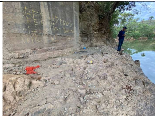
Foto 6: Estrutura da fundação da ponte. Alex Alves, 30 mai.
