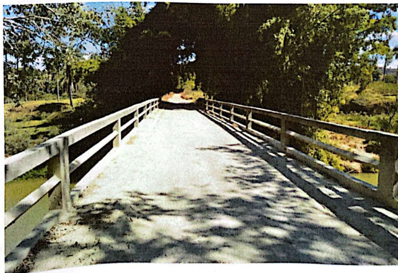
Ponte sobre o Indaiá. Foto: Norma Borges, Julho de 2017.
