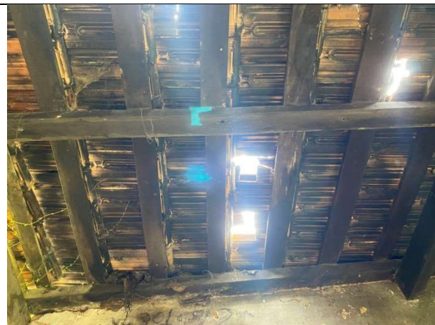
Foto 6: Vista interna da cobertura. Alex Alves, 30 mai. 2023.
