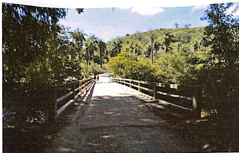
Ponte sobre o Indaiá. Foto: Norma Borges, julho de 2017.
