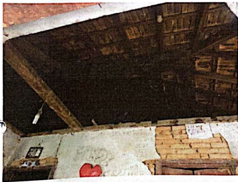
Ausência de Forro na Fazenda do Batista. Foto: Norma Borges, julho de 2017.
